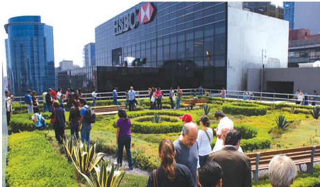
Oficinas corporativas de un Banco sobre Reforma, naturación en el décimo piso
